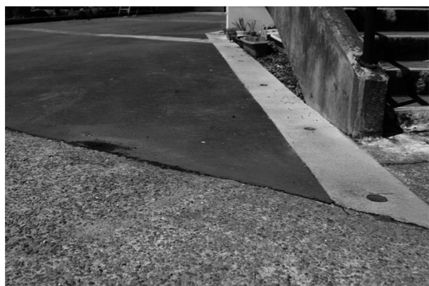
一部、新たな消雪パイプを設置しました (2013年秋)
